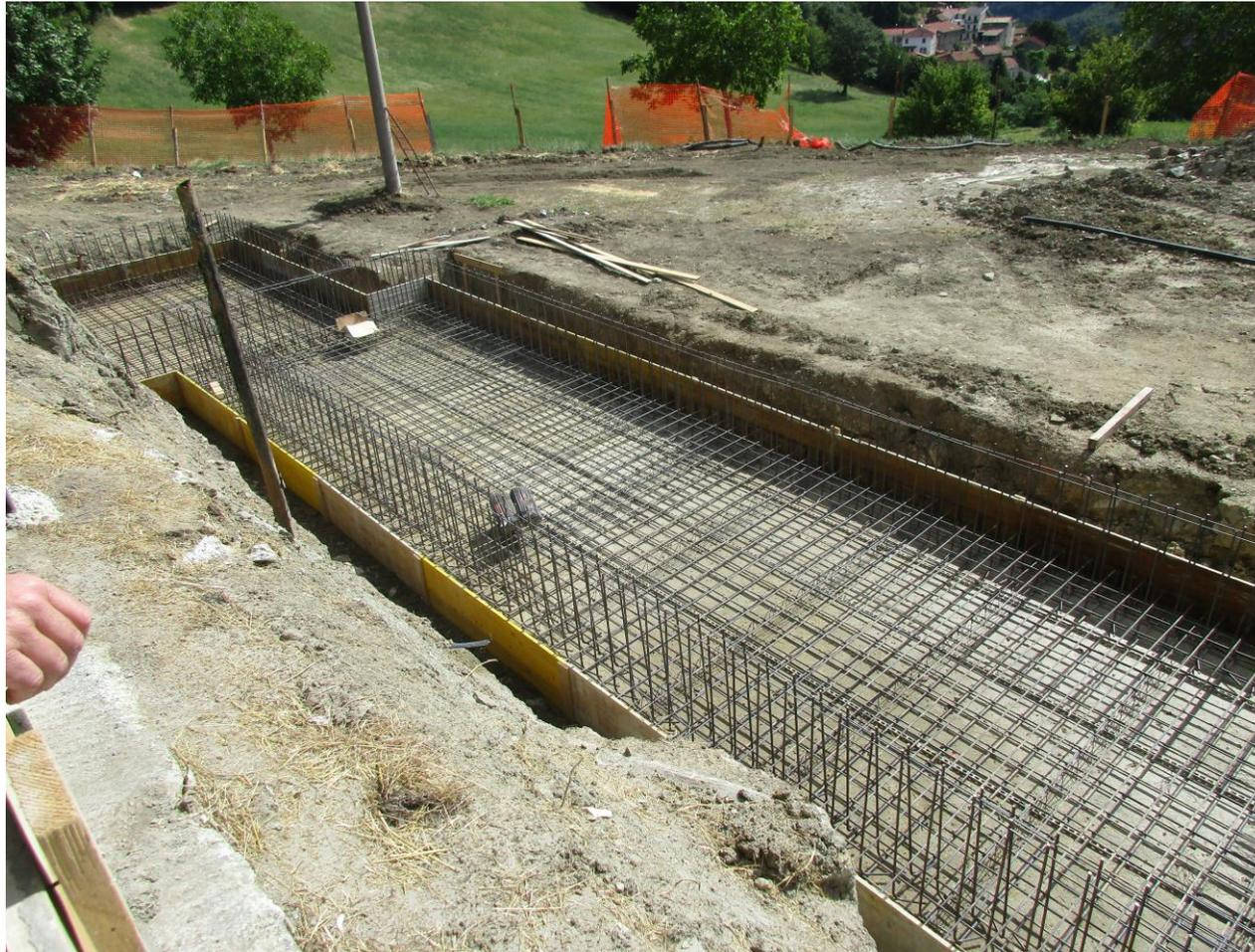
Realizzazione di manufatti in cemento armato per ampliamento stalla a Petrignacola di Corniglio
